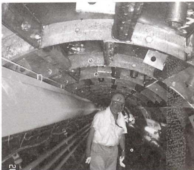
(遠賀川川底下5m付近にて)
